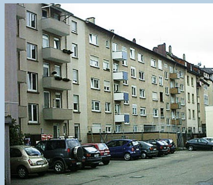
Die Mietshäuser vor und nach der Sanierung
